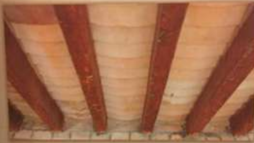
中式雙層瓦頂及桁架結構 (攝於2010年) Chinese Double-layered Roof and Truss Structure (Photo taken in 2010)
